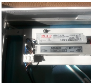
Přípojovací konektor 230V/50Hz
